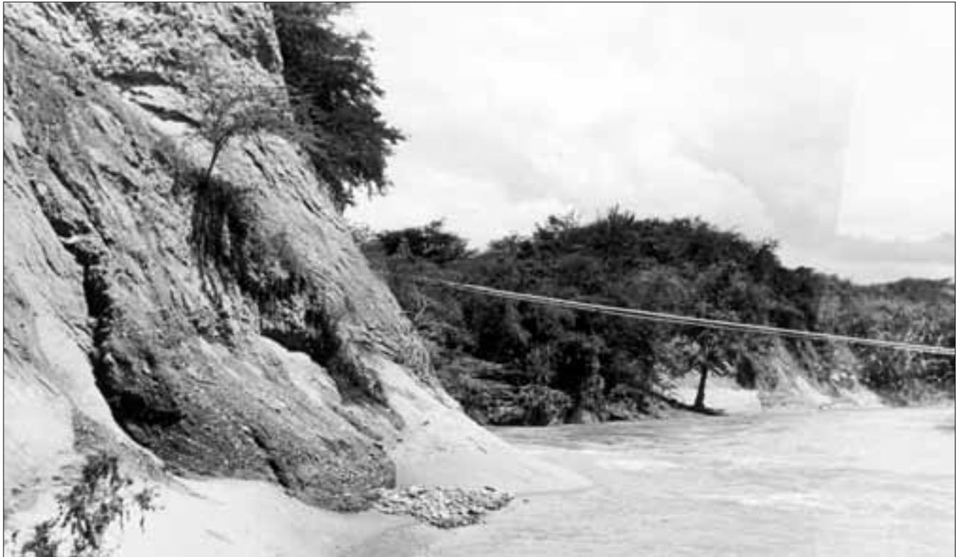
Barrancas del río Ámina donde observamos, por primera vez, los nidos de carpinteros ( Melanerpes striatus ). La tubería colgante es usada por los campesinos para llevar al otro lado del Ámina el agua que sacan de un canal.
